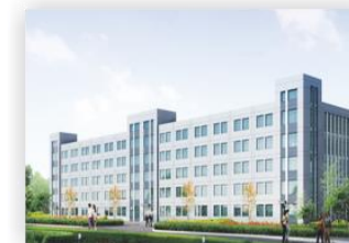
天津联通数据中心 Tianjin Unicom Data Center
