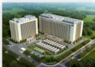
北京阿里巴巴金汉王数据中心 Beijing Alibaba Jinhawang Data Center
