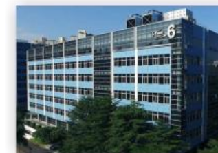
深圳招商证券数据中心 Shenzhen China Merchants Securities Data Center
