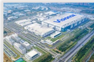
维信诺（合肥）G6全柔AMOLED生产线项目
