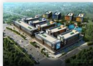
北京盘古万国数据中心 Beijing Pangu Wanguo Data Center
