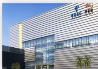
佛山电信开普勒数据中心 Foshan Telecom Kepler Data Center
