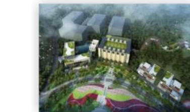
广东电信云浮数据中心 Guangdong Telecom Yunfu Data Center
